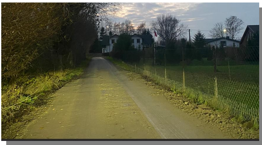
dz. drogowa nr 255 w Rusowie (droga dojazdowa do cmentarza)
